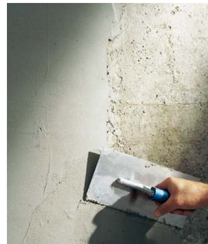
Aufbringen von Innenputz
