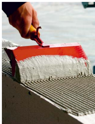
Auftragen von Dünnbettmörtel
